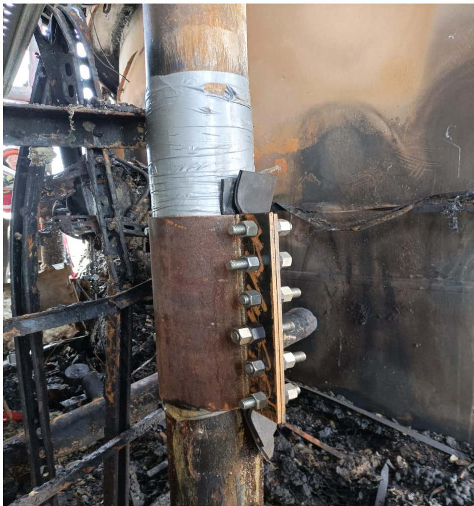
Фото 2 - Трубопровод после пожара (на месте разрыва установлен хомут)
